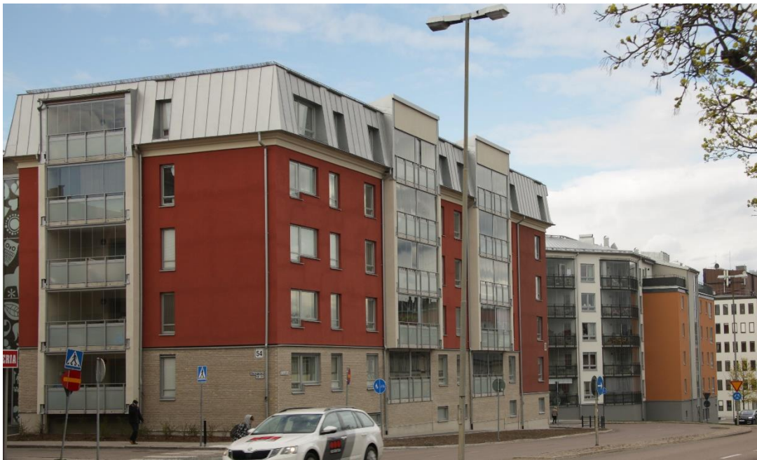
Nybyggda flerbostadshus vid Gruvgatan
