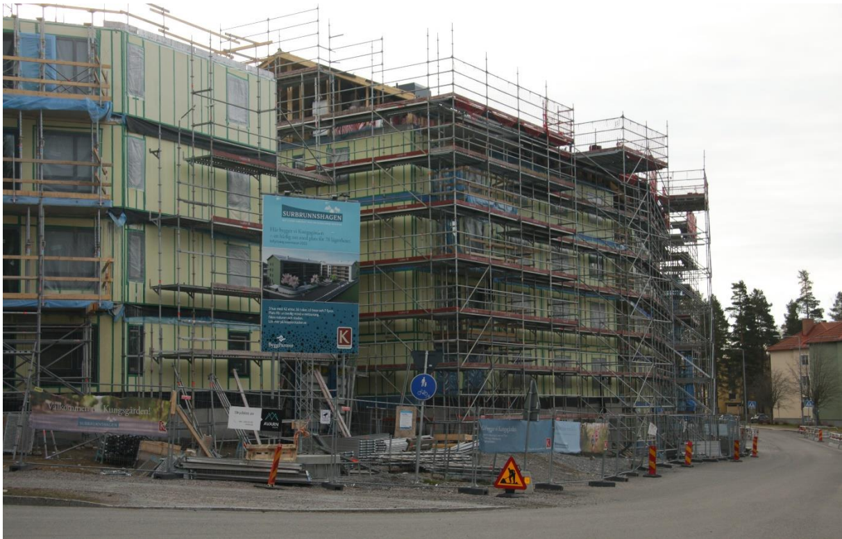
Pågående byggnation av Kopparstadens projekt Kungsgården i Surbrunnshagen
