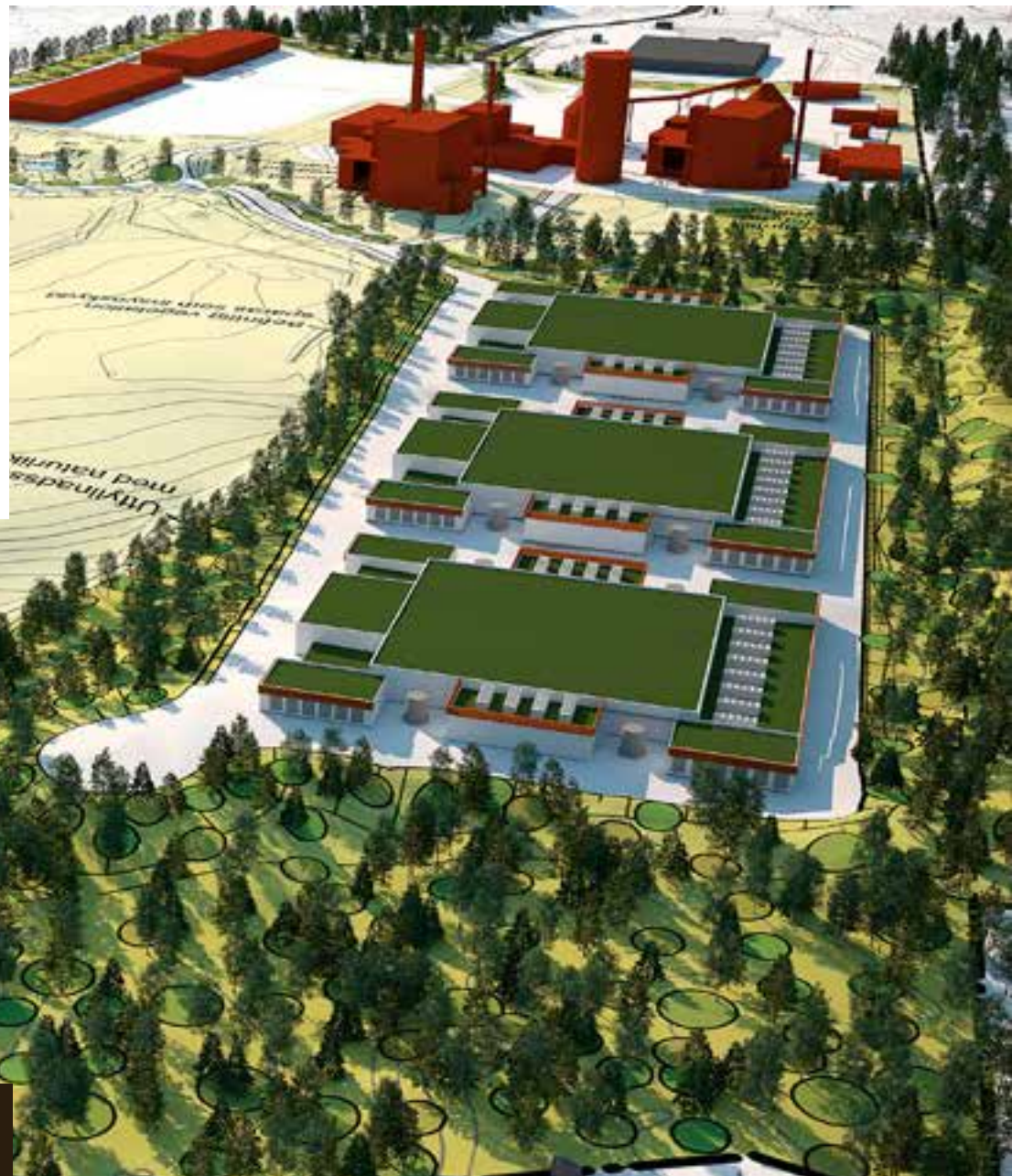
När allt är klart kommer centret att innehålla cirka 3000 serverplatser med hög säkerhet, kraftfull strömförsörjning och ett smart system för att återanvända värmeenergin. Skiss: SWECO arkitekter.
